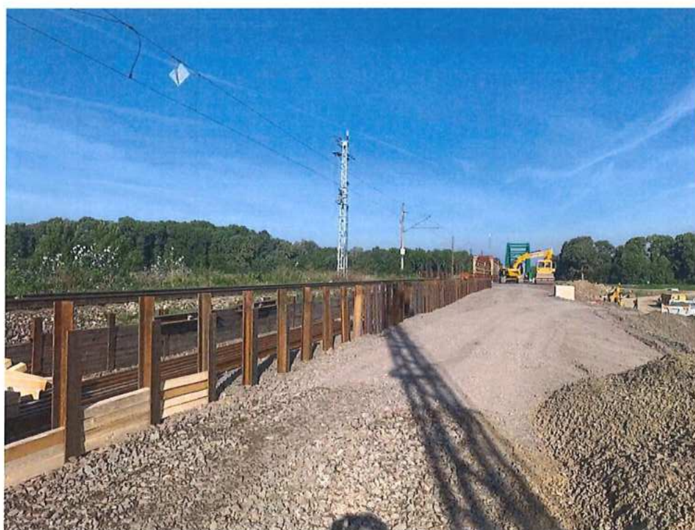
Realizácia záporového paženia medzi TK1 a TK 2
