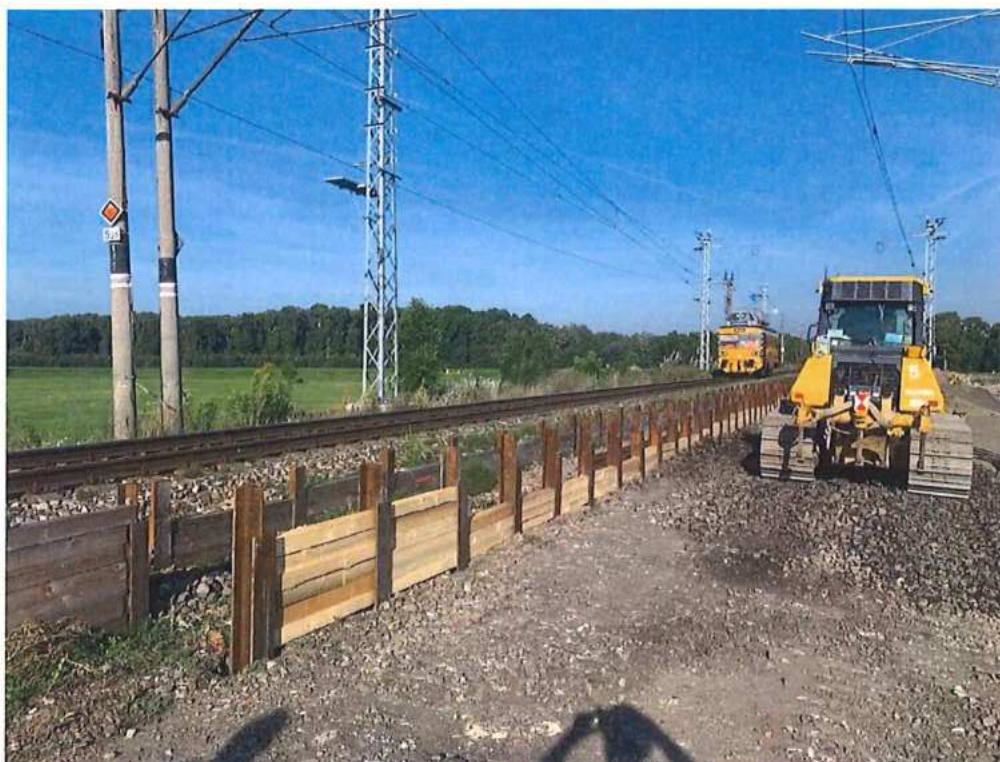
Realizácia záporového paženia medzi TK1 a TK 2
