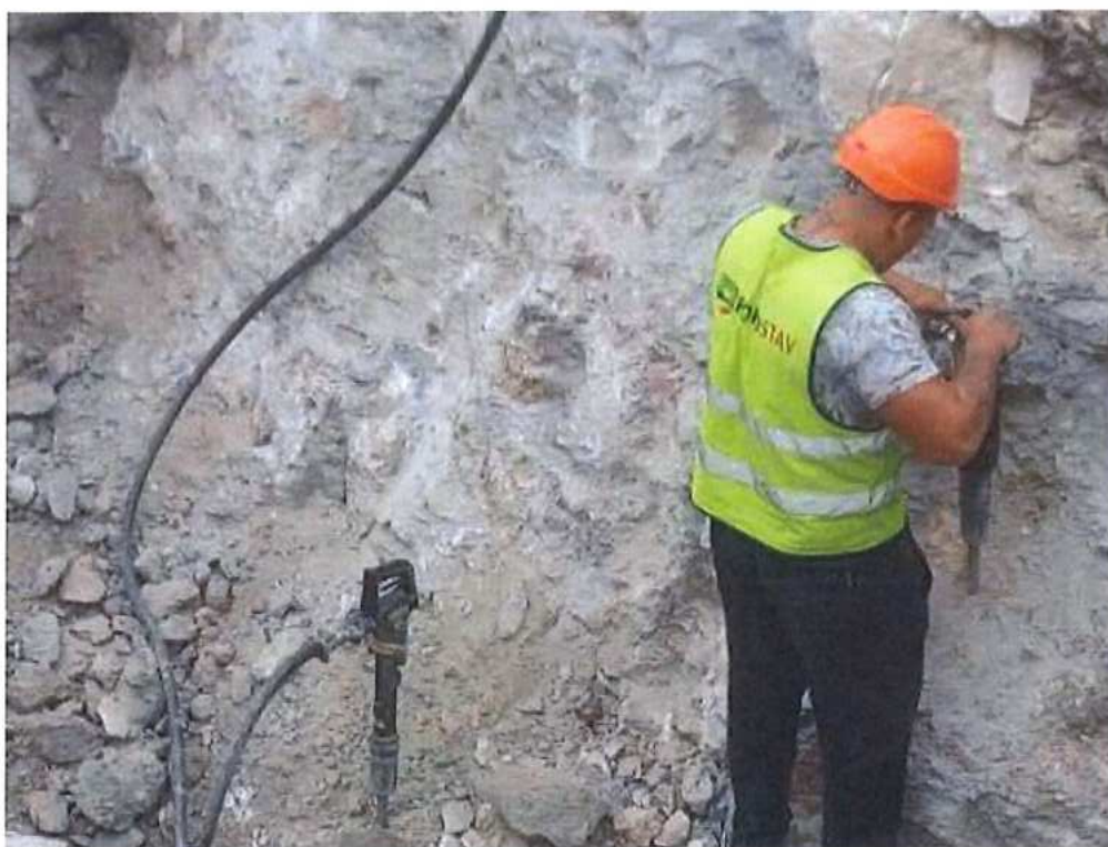
Búranie pôvodného základu – ručne – SO 12-33-02
