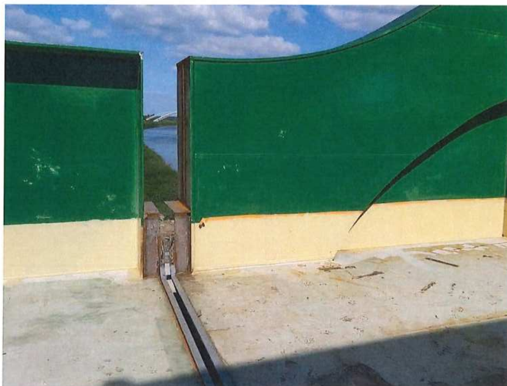
Montáž dilatácií – SO 12-33-04
